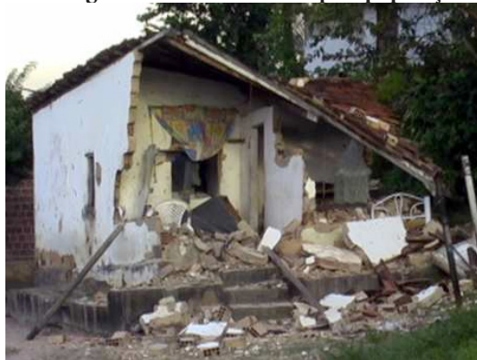
Figura 6. Casa dos agressores semidemolida pela população do bairro
