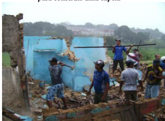
Figura 7. A casa das vítimas foi demolida pelos próprios vizinhos, para construir uma capela
